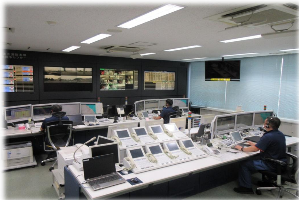
久慈消防本部通信指令室
