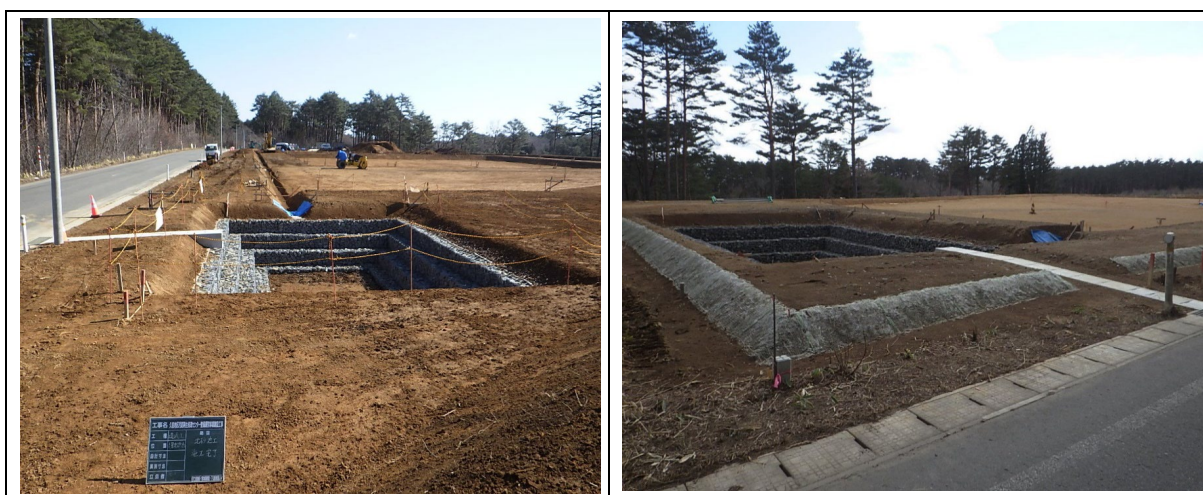
写真-1 仮設沈砂池等の設置状況
