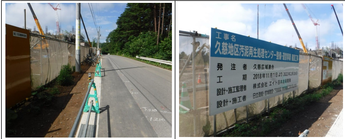
写真-2 粉じん防止ネットの設置
