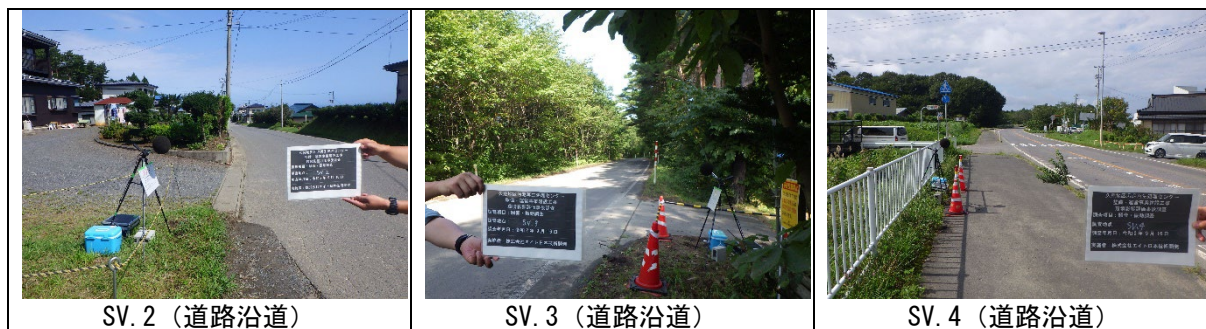
写真-1 調査地点（工事中）
