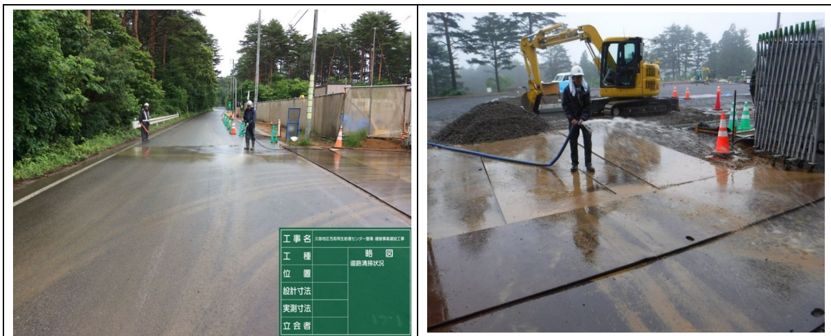
写真-3 散水及び養生敷設の状況
