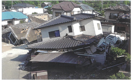
地震による被害例（熊本地震）
